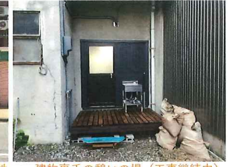
建物裏手の憩いの場 (工事継続中)
