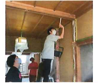
学生による改修工事
